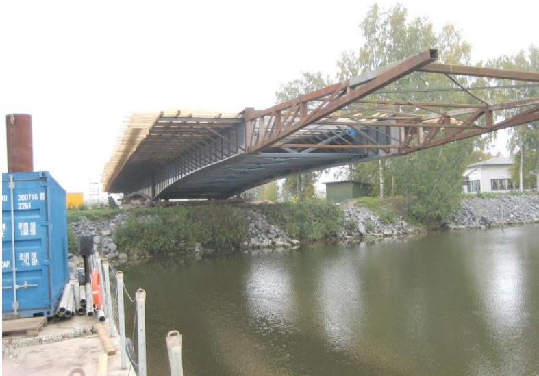
Figur 1. Lansering av finsk bro med K-fackverk mellan underflänsarna.
